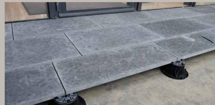
I supporti Impertek sono stati scelti perché coniugano stabilità, efficienza e rapidità di realizzazione con facilità e precisione nella posa. PEDESTAL LINE è la più completa gamma di prodotti per la realizzazione di pavimenti flottanti ed è in grado di offrire soluzioni per ogni esigenza costruttiva.
